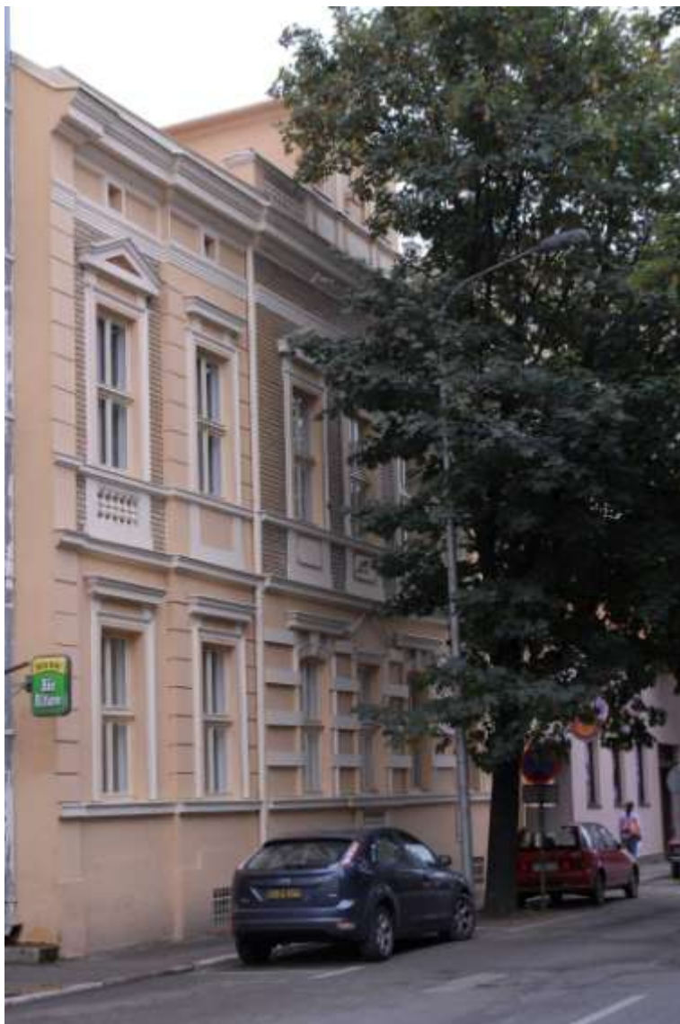
1. Поглед на зграду седишта Суда из правца раскрснице улица ЈНА и Железничке
