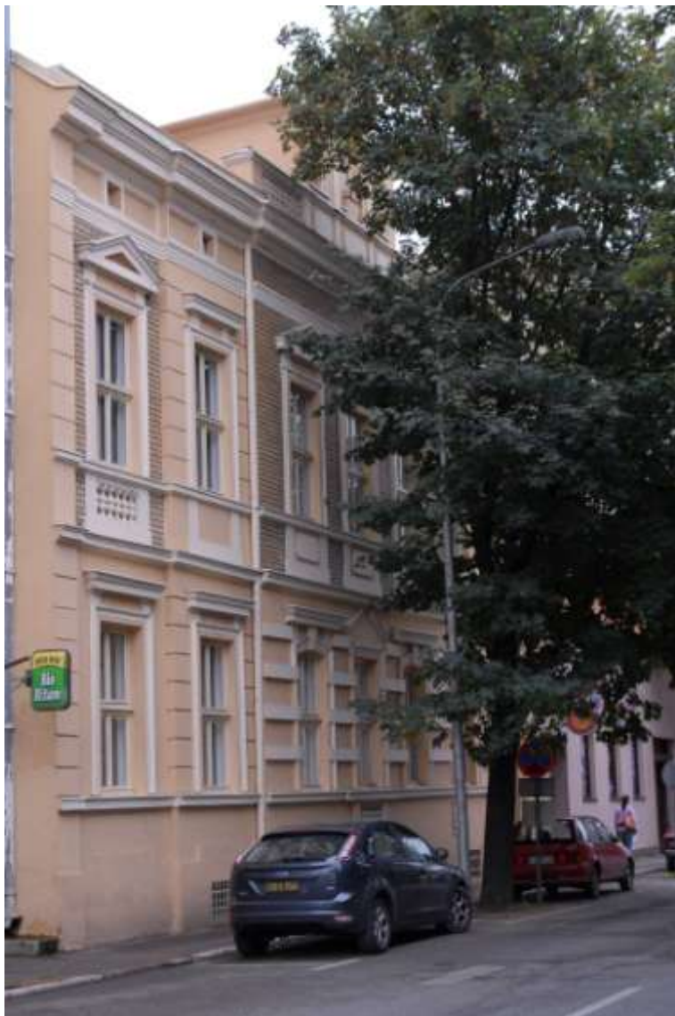
1. Pogled na zgradu sedišta Suda iz pravca raskrsnice ulica JNA i Železničke
